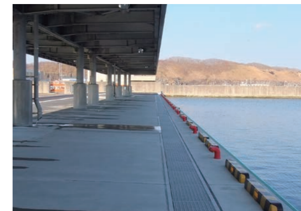
北海道登別漁港建設工事
