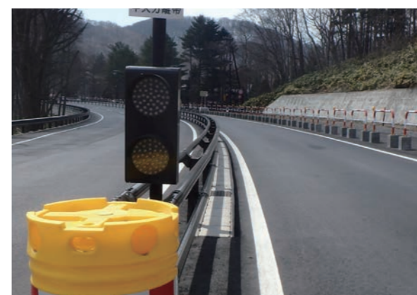
北海道一般国道5号七飯小沼舗装工事
