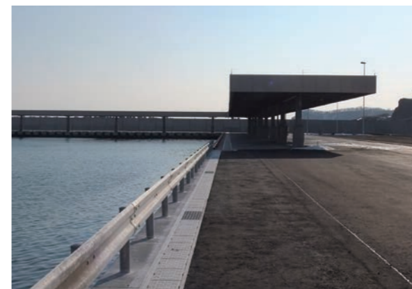
北海道登別漁港建設工事
